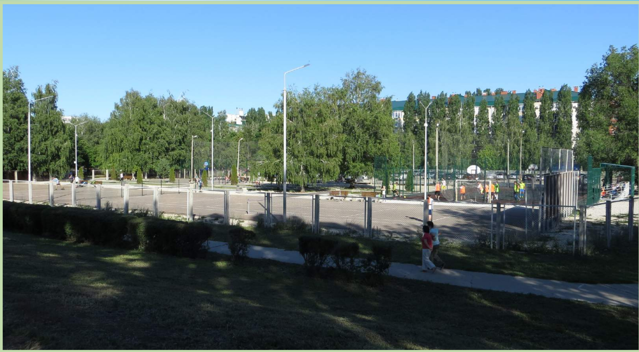
устройство спортивной площадки с антитравматическим покрытием
